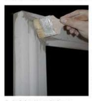
dadurch wird ein Strukturunterschied am Profil vermieden. An den Außenseiten der Profile (zwischen Wand und Profil) soll der Kleber ebenfalls satt austreten. Dieser wird mit einer kleinen Rundspachtel abgezogen und mit einem nassen Schwamm abgezogen. Die Profile sollten mit einer Latte oder Brett an die Wand gedrückt werden um eine ebene Montage zu erreichen.
