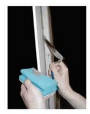
Der überschüssige Kleber wird nun mit einer Spachtel entfernt.
